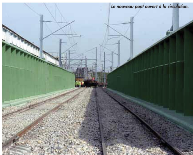
Le nouveau pont ouvert à la circulation.
