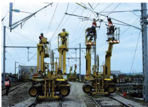
Déplacement des caténaires au-dessus du nouveau tracé de la voie ferrée
